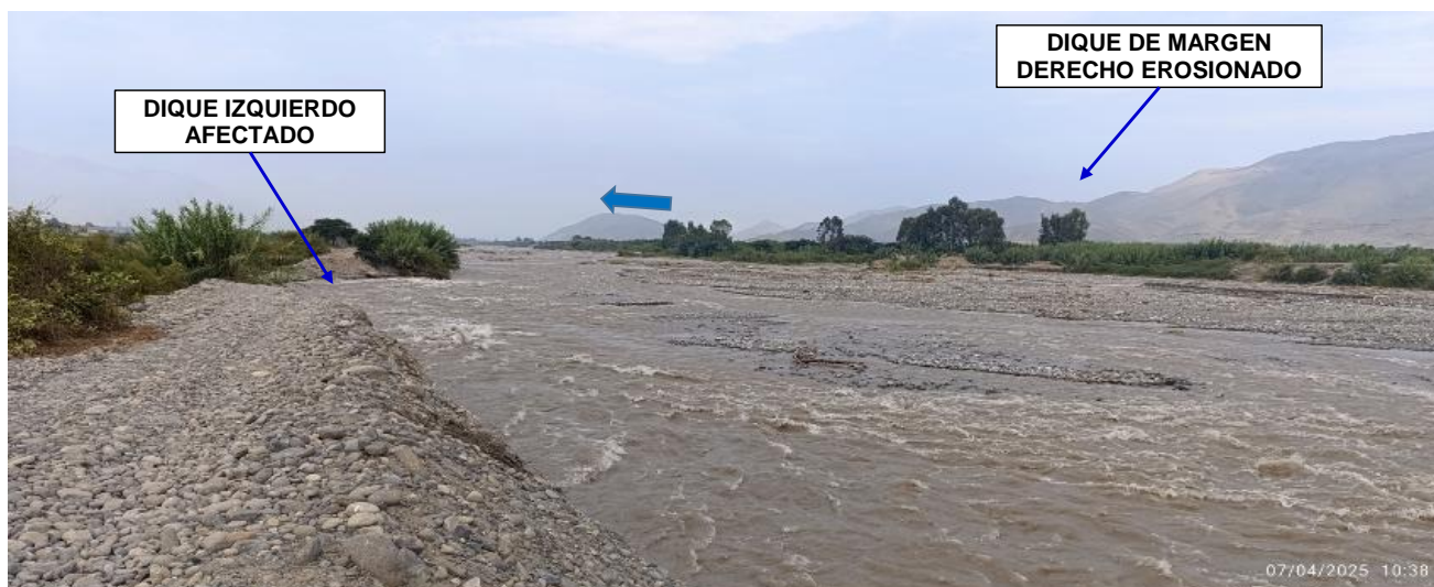
FIGURA N°04: RIO CHANCAY HUARAL, CON LA MARGEN IZQUIERDA AFECTADO POR EROSION QUEDANDO SIN DIQUE, EL CAUCE COLMATADO Y MARGEN DERECHA CON EL DIQUE EROSIONADO POR EL CAUDAL CON RIESGO A QUEDAR SIN DIQUE.
