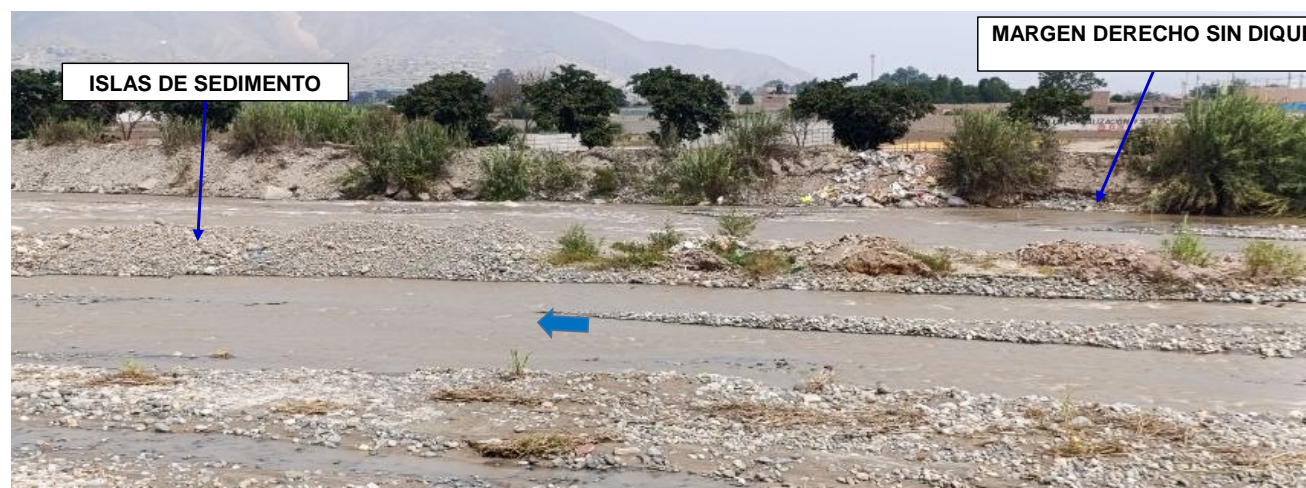
FIGURA N°02: RIO CHANCAY HUARAL EL CAUCE PRESENTA ISLAS DE SEDIMENTOS Y MONTICULOS DE ARENA, DESVIANDO EL CAUDAL HACIA LOS BORDOS CAUSANDO EROSION EN LOS DIQUES Y TRAMO EN LA MARGEN DERECHA AFECTADO.
